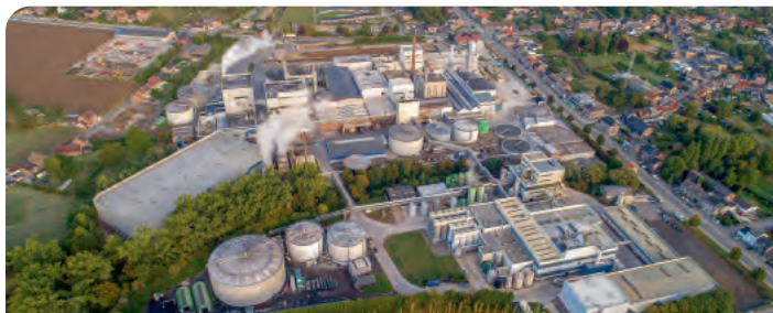
Der Energieverbrauch pro Tonne verarbeitetes Produkt soll am belgischen Standort Oreye bis 2030 mehr als halbiert werden. Foto: Beneo
